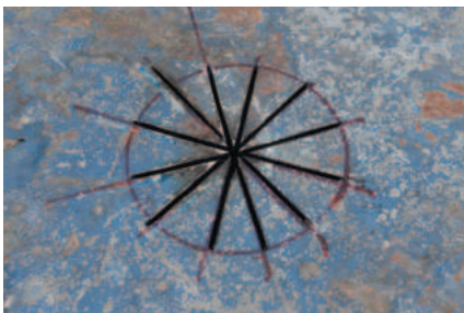
4 ฝาถึงตัดเจาะแล้วเสร็จ
