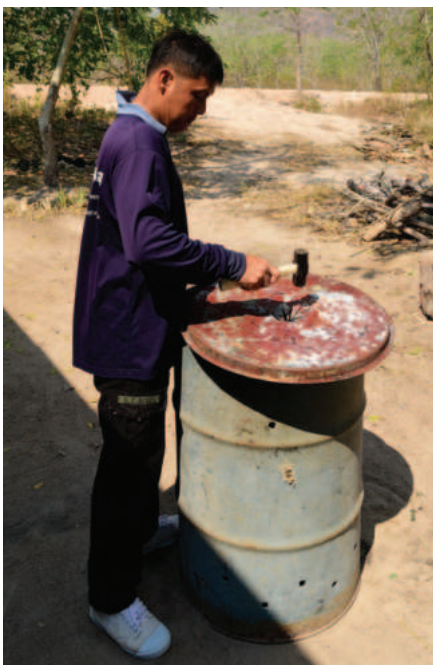
5 ใช้ค้อนตอกจากด้านในฝา ให้รอยตัดเจาะนั้นเปิดออก
